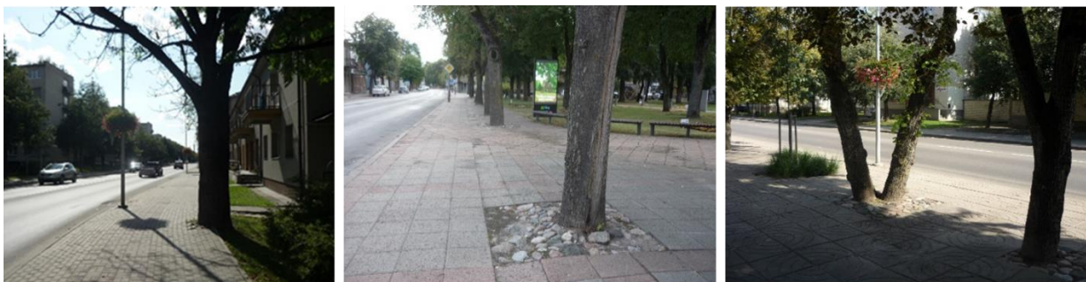
14 pav. Esama situacija: korekcijų reikalinga sisteminė klaida Anykščių mieste, itin bloginanti esamų medžių būklę – mažos, kietosiomis dangomis apribotos augimvietės ir pakeltas grunto lygis ties medžio šaknų kakleliu
